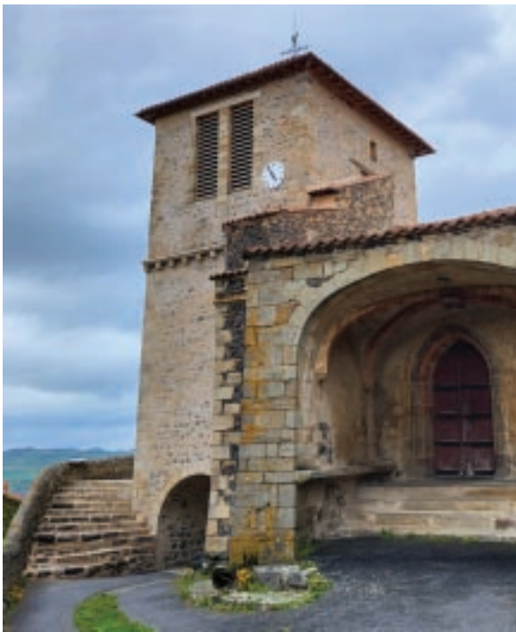
Clocher et son belvédère restaurés. Les angles du clocher ont été brochés avec des tiges d’acier inox de 3 m de longueur afin d’en assurer la stabilité.
