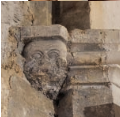
Suite à la consolidation du clocher, les anciens contrefort du Narthex ont pu être démontés, découvrant l’ensemble des ogives de la voûte avec leurs culots auparavant murés.
