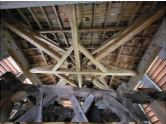
Clocher et son belvédère restaurés. Les angles du clocher ont été brochés avec des tiges d’acier inox de 3 m de longueur afin d’en assurer la stabilité.
