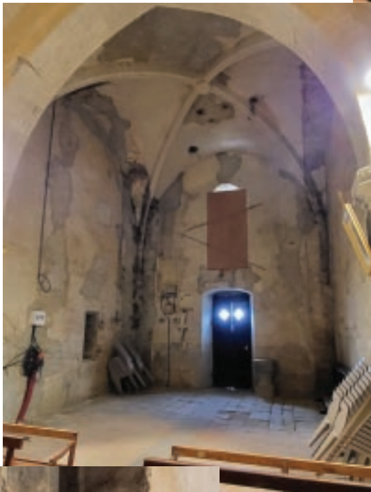
Suite à la consolidation du clocher, les anciens contrefort du Narthex ont pu être démontés, découvrant l’ensemble des ogives de la voûte avec leurs culots auparavant murés.
