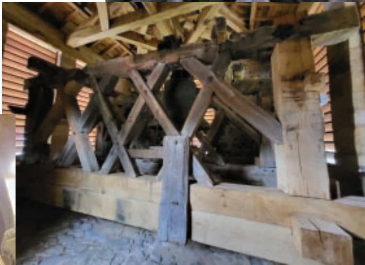
Charpente et Beffroi restaurés dans les règles de l’art. La pente du toit a été ramenée à celle d’origine couverte de tuiles canal
